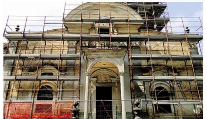
La chiesa di San Bartolomeo a Sordio, dove è stato avviato il cantiere
