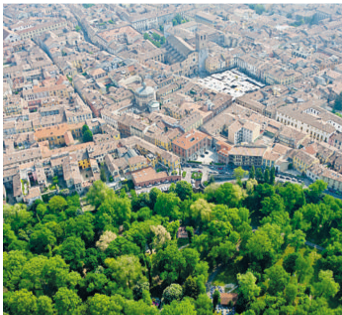
Dal centro di Lodi fino alle "periferie" della Diocesi il cammino è condiviso
